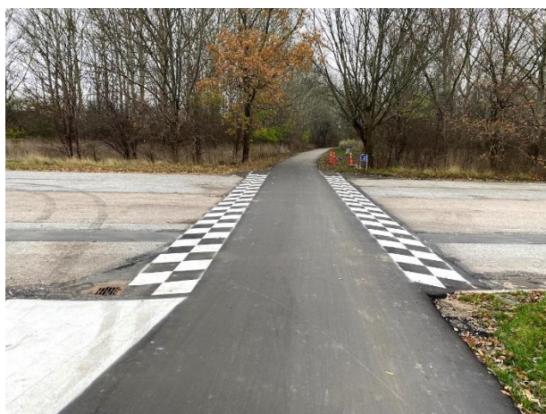
Figur 4 Efter anlæggelse af hævet overkørselsflade ved Tårnfalkevej i Hvidovre Kommune. (foto: Sekretariatet for Supercykelstier)
