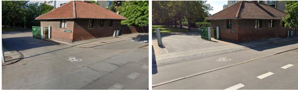
Figur 9 Før og efter etablering af gennemført fortov og cykelsti ved indkørslen til Søndermark Kirkegård i Frederiksberg Kommune. (foto: Google Street View)
