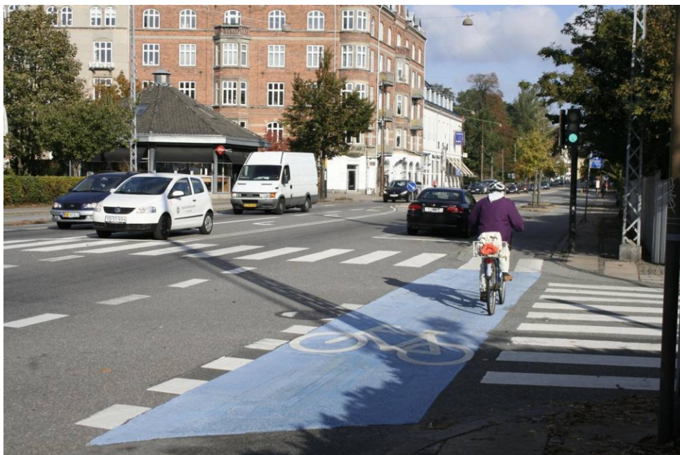
Brug af cykelfelter afgrænset af bred punkteret linje og evt. blå farve kan anvendes i kryds, hvor der vurderes at være særlige behov for opmærksomhed fra svingende biltrafik (Gentofte Kommune).
